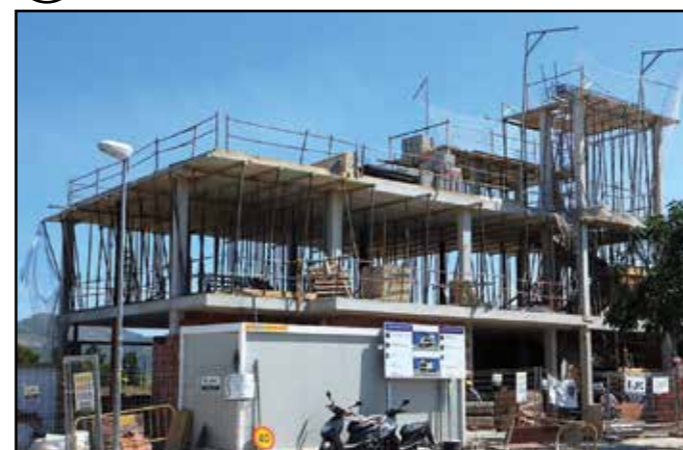
5 Bygget er kommet halvveis
